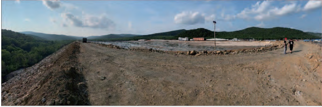
圖8-7：目前尾礦庫設施，由東南面望向西北面
